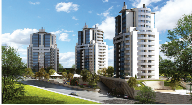
Fuzul İnşaat Arriva - Başakşehir
